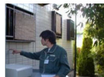
外壁の状態を確認
