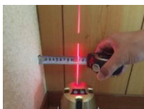
建物の傾きの確認
