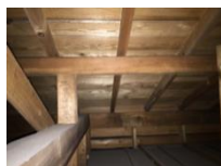
小屋裏に雨漏りの跡がないか
