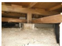
床下にシロアリ被害がないか
