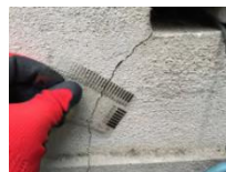
基礎のヒビ割れの確認
